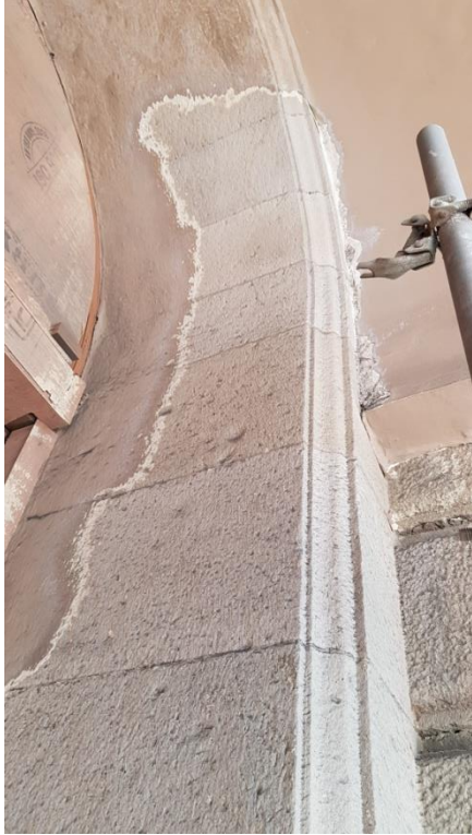
Copper slag blasting
